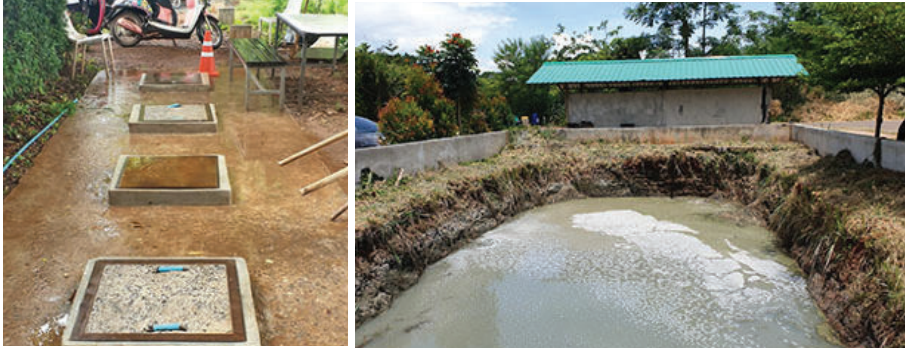
การติดตั้งระบบบำบัดน้ำเสีย และระบายสูบน้ำบริเวณร้านอาหาร
