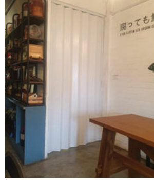
แบ่งโซนพื้นที่ปรับอากาศ โดยใช้มานาน เพื่อลดการใช้พลังงาน
