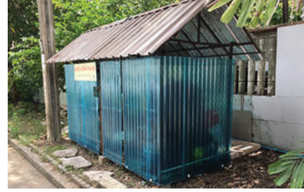
ปรับปรุงจุดพักขยะให้มีหลังคาคลุม กันแดดกันฝน อากาศถ่ายเทได้ดีและ ไม่เป็นแหล่งอาศัยของสัตว์พาหะนำโรค
