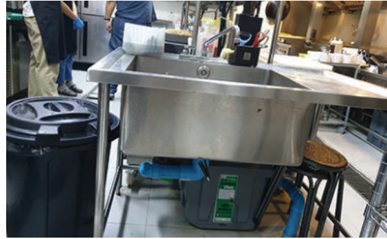
ติดตั้งบ่อดักไขมันใต้อ่างล้างจาน
