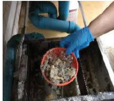
นำน้ำแข็งเหลือใช้จากห้องอาหาร มาเทลงบ่อดักไขมันเพื่อให้ไขมันจับตัวเป็นก้อน สะดวกต่อการตักไขมัน
