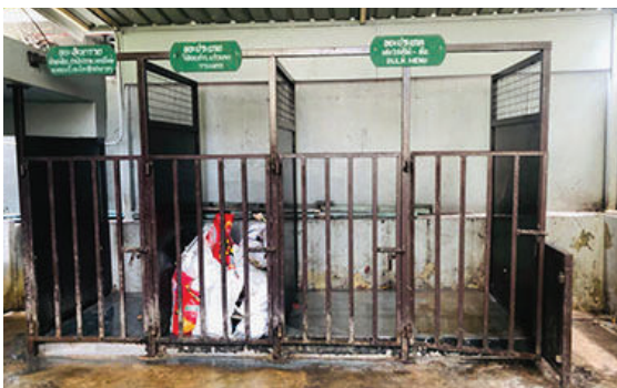
จุดพักขยะรอส่งกำจัดที่มีหลังคาคลุม กันแดดกันฝน อากาศถ่ายเทได้ดีและไม่เป็นแหล่งอาศัยของสัตว์พาหะนำโรค
