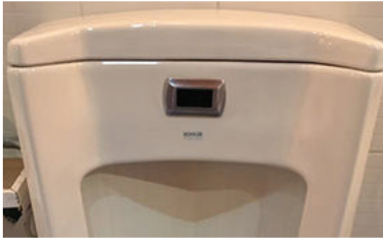
ติดตั้งโถปัสสาวะชายแบบเซนเซอร์ เพื่อประหยัดน้ำ
