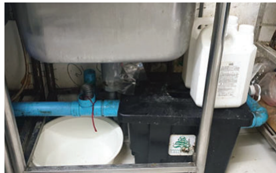
ติดตั้งถังดักไขมันใต้อ่างล้างจาน
